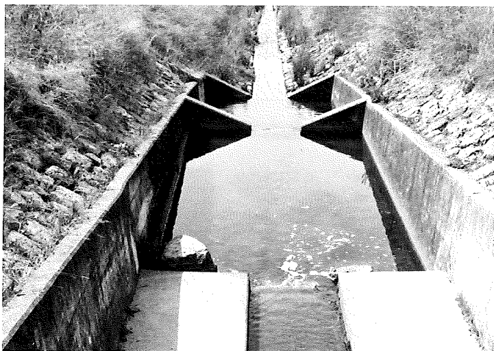
Der kanalisierte Haslibach
