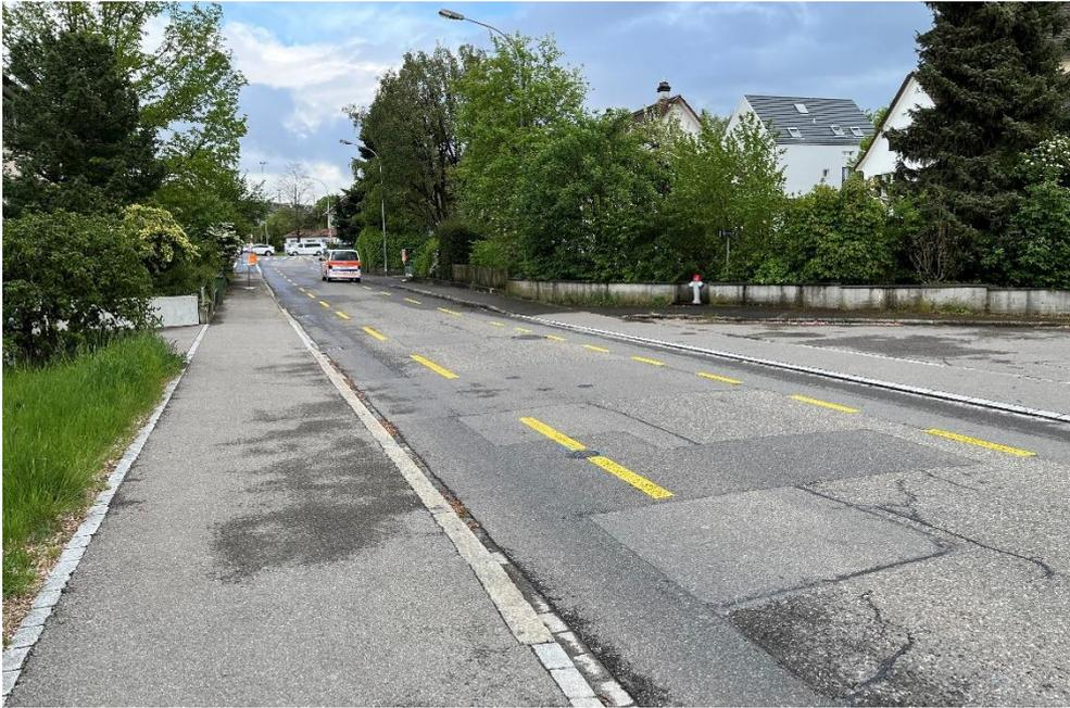
*An der Brandstrasse in Uster wurde eine Kernfahrbahn mit 1.5 m Radstreifen, 3.0 m Kernfahrbahn und 1.5 m Radstreifen bei einem DTV von 2'500 Fz./d und 500 Velo/d eingerichtet. Er funktioniert einwandfrei. Ist allerdings deutlich weniger stark befahren.*
