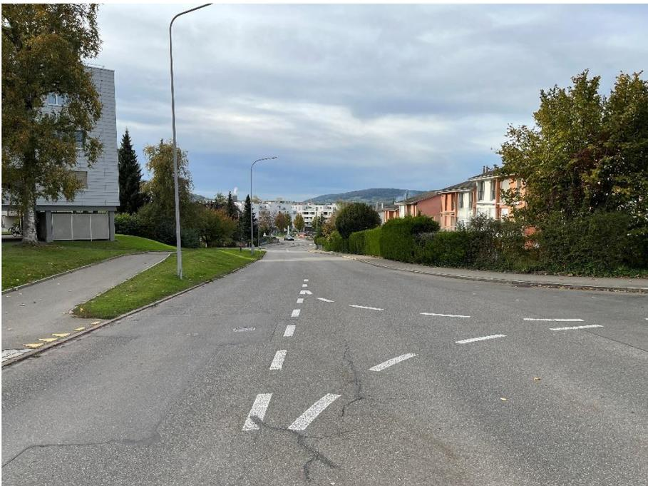
*Risse und Flicke bei Einmündung der unteren Heiselstrasse.*
