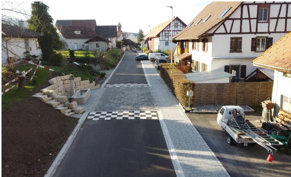
*Dorfstrasse Schleinikon, Gehweg und Brunnenplatz aus Betonverbundsteinen. Leichte vertikale Versätze mit Schachbrettmustern wurden zusätzlich bei den Einmündungen angeordnet (nur schemenhaft erkennbar im Hintergrund).*
